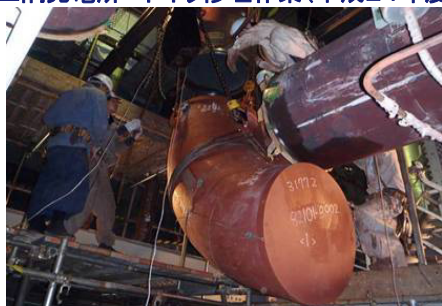
【三隅発電所 ボイラ修理作業(平成24年度)】
