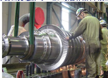
【新小野田発電所 タービン取替作業(平成23年度)】
