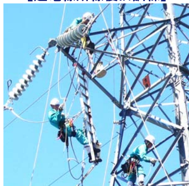
【送電線断線復旧訓練】
