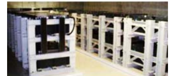
直流電源の強化として、既設の蓄電池の取替および追加設置
