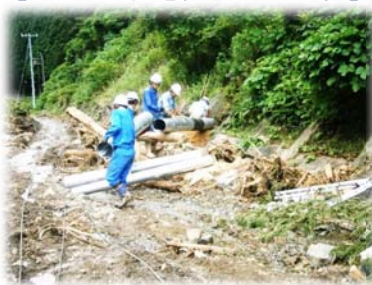
【分割型の仮電柱を人力で運搬】
