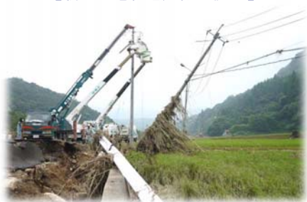
【新しい電柱を建設し復旧】
