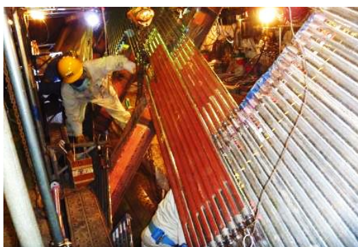
【ボイラ蒸発管取替】
