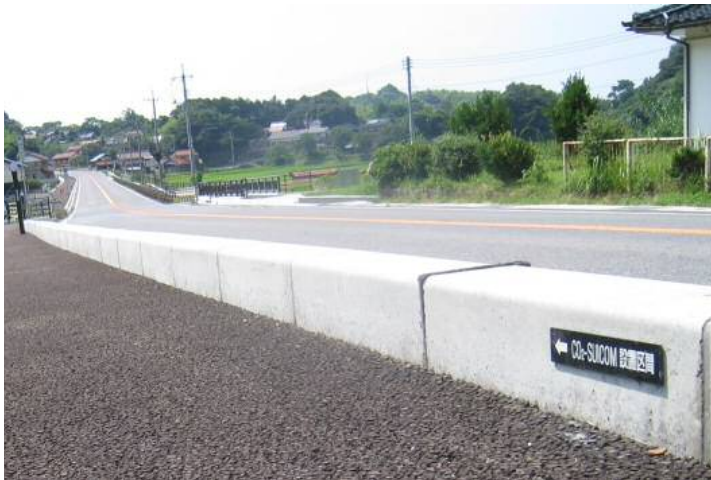
【国道9号線歩車道境界ブロック】
