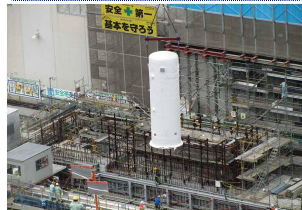
フィルタ装置の吊り込み
