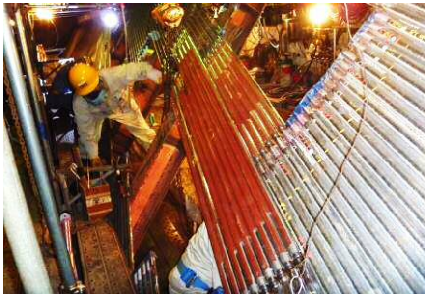
【ボイラ蒸発管取替】
