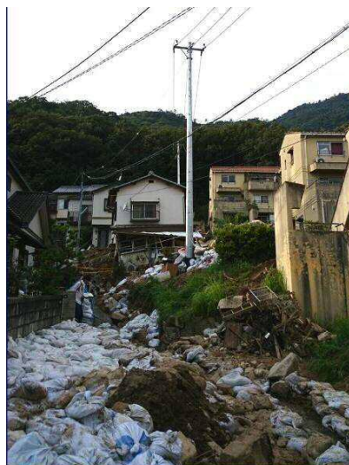
【分割式の鋼管柱を 人力で搬入・建柱】
