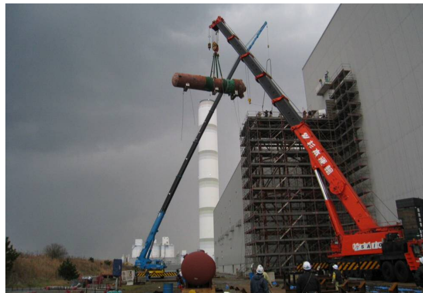
【給水加熱器修理】
