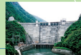
新成羽川発電所(新成羽川ダム) 1~4号 30.3万kW
