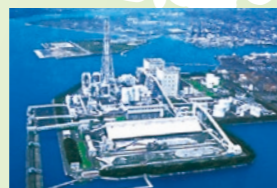
新小野田発電所 1号 50万kW、2号 50万kW
