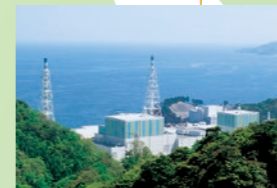
島根原子力発電所 2号 82万kW (3号 137.3万kW 工事中)
