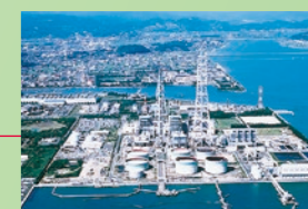
玉島発電所 1号 35万kW、2号 35万kW、3号 50万kW
