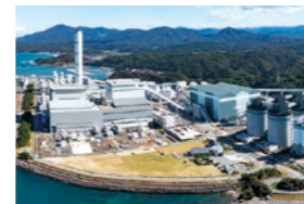
三隅発電所 1号 100万kW 2号 100万kW
