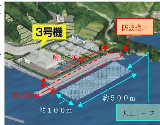
図：島根原子力発電所3号機 防波護岸
