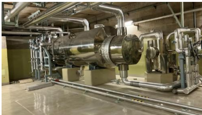
2025年度解体工事着手設備 （タービングランド蒸気発生器室内）
