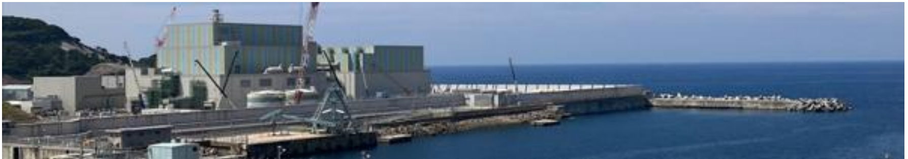
島根3号機建設状況
