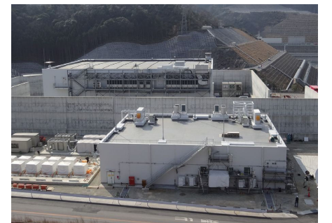
緊急時対策所
